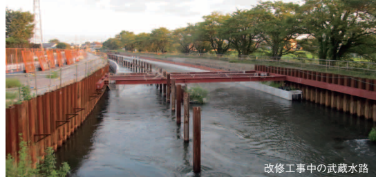
改修工事中の武蔵水路
